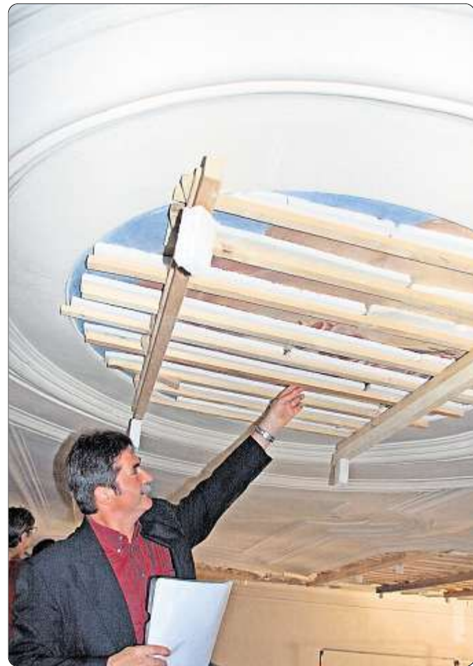
Architekt Thomas Peetz zeigte es schon länger auf, dass die Deckenfreske gesichert wurde. Eine Restaurierung ist unumgänglich.
